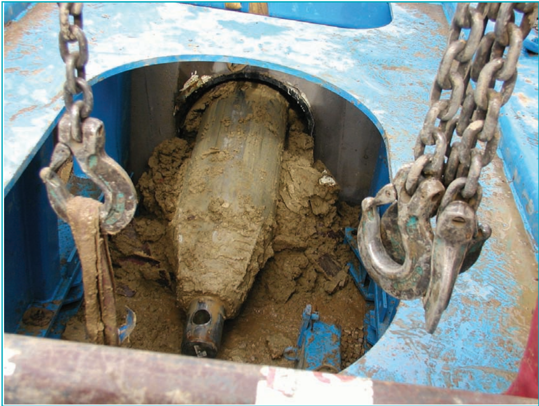
El tramo de tubería de 120 m instalada
