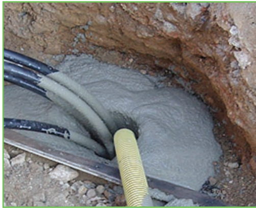
Inyección de Hormigón-bentonita.
