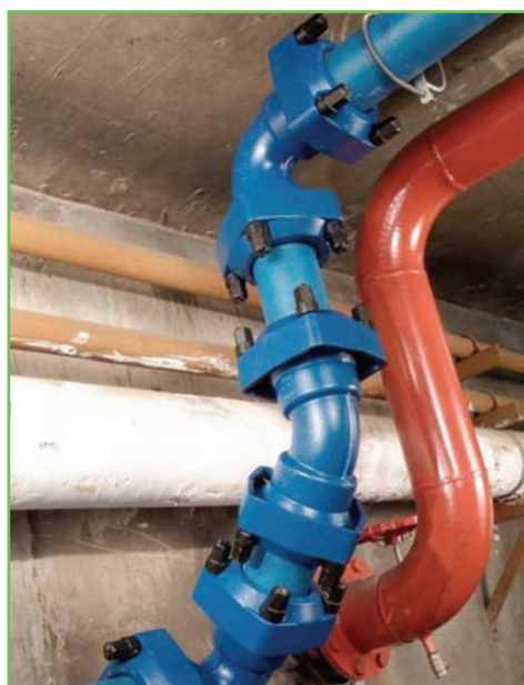
Tuberías sin KAMELEO
