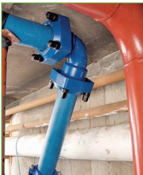
Tuberías con KAMELEO
