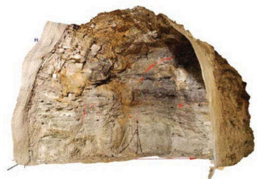
Figura 14. Imagen 3D de un túnel junto con las paredes laterales. La imagen 3D consiste en 4 modelos individuales que fueron fundidos en una imagen 3D. Las imágenes 3D fueron sacadas desde posiciones diferentes mirando hacia el frente, las paredes laterales y el techo.
