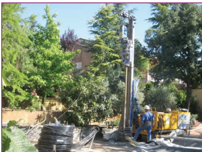
Fig. 1. Instalación de la sonda geotérmica “Doble U” a 120 m de profundidad
