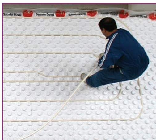
Fig. 2. Instalación de suelo radiante
