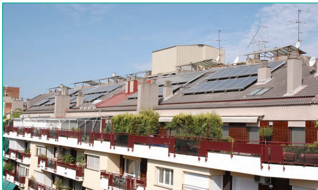
Fig. 1 - Renovación integral de una instalación de energía solar térmica en un edificio de viviendas de más de 25 años de antigüedad.
