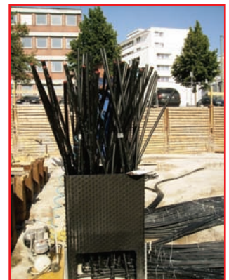
Foto 7 y 8. Cubierta para la inserción de las tuberías
