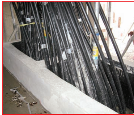
Foto 7 y 8. Cubierta para la inserción de las tuberías
