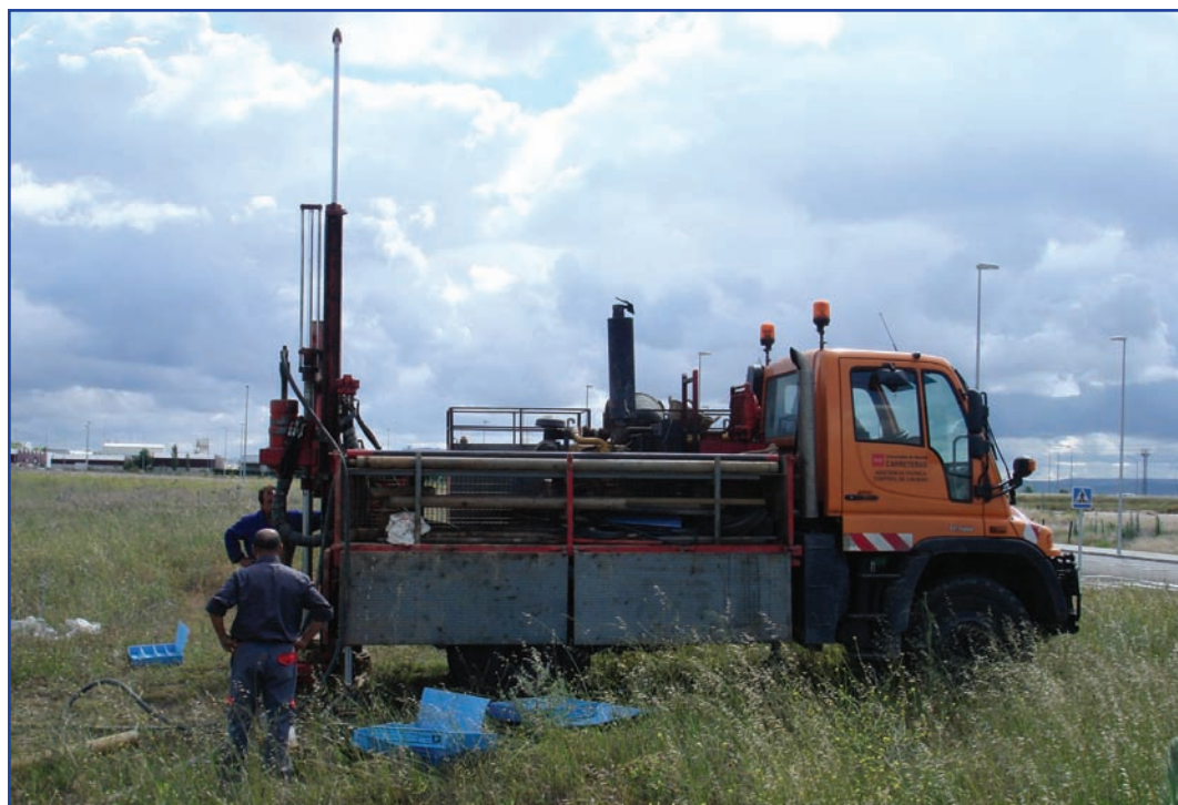
Equipo de exploración geotécnica
