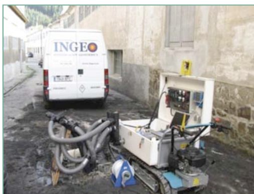
Figura 2. Test de Respuesta Geotérmica
