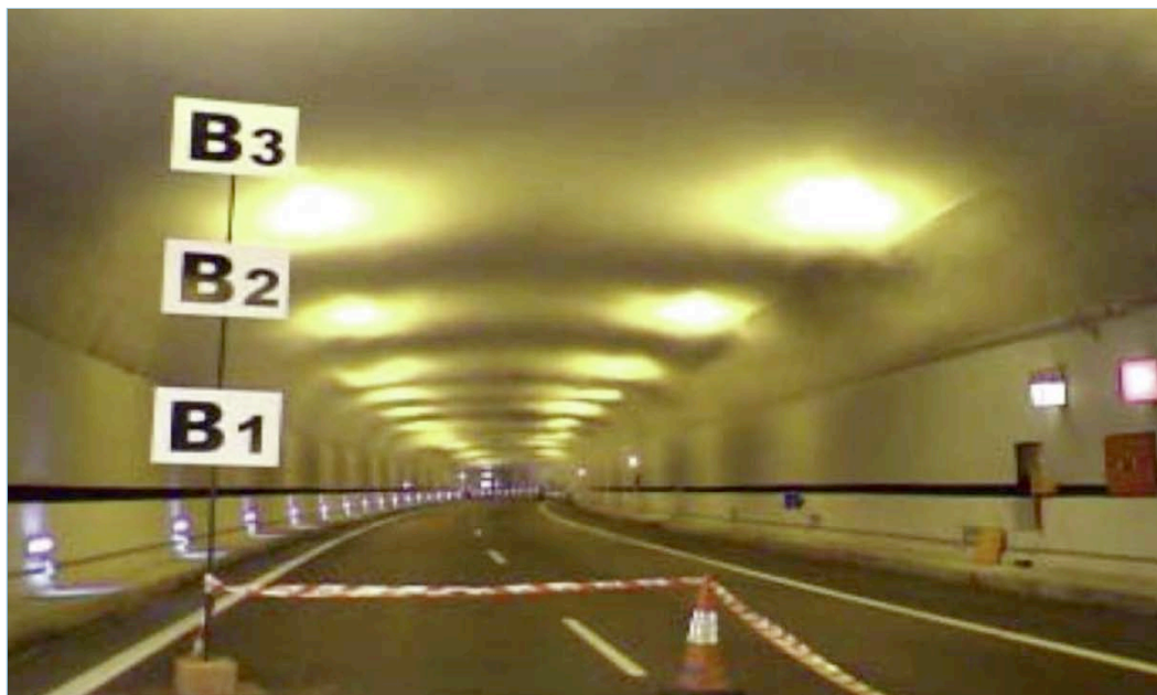
Estratificación y control del humo durante el ensayo realizado
