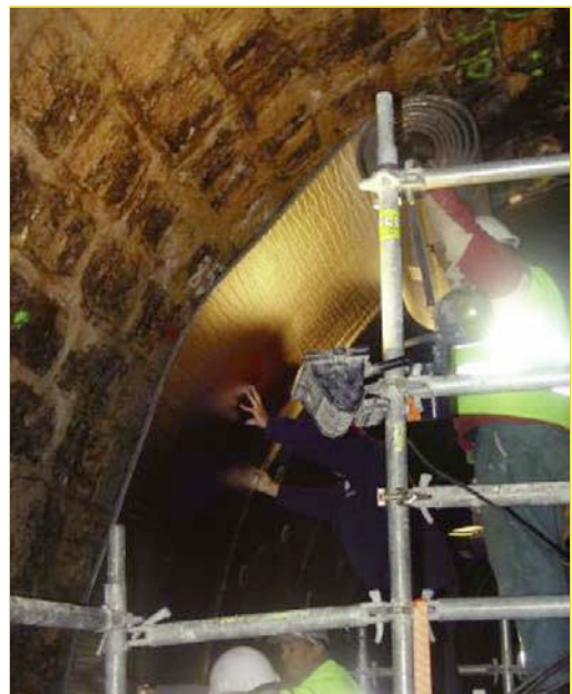
Trabajos en los túneles de Saut et Morillon
