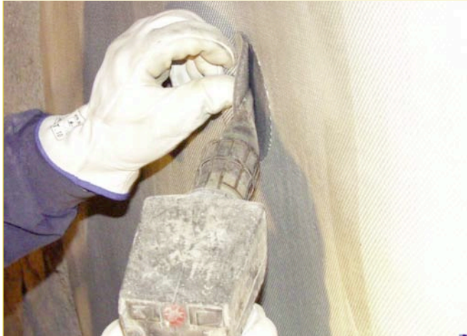
Proceso de instalación: fijación de los anclajes
