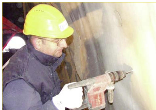
Proceso de instalación: fijación de los anclajes
