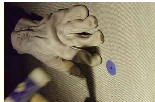
Proceso de instalación: fijación de los anclajes
