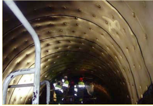
Trabajos en los túneles de Saut et Morillon
