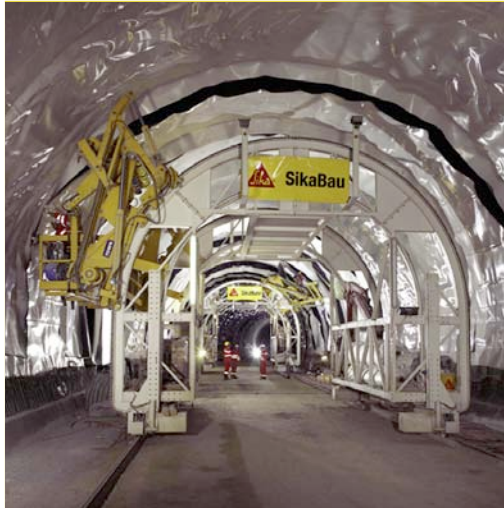
el anillo de hormigón de revestimiento.
