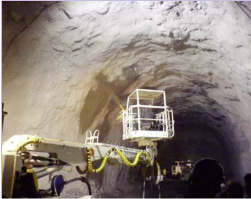
Fig.5: Proyección del hormigón con fibra
