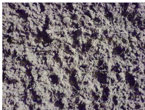
Fig.4: Aspecto del hormigón con fibra
