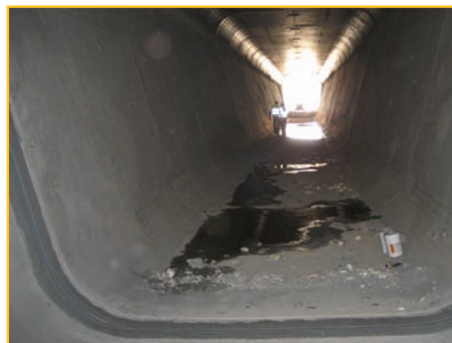
Masterflex 3000 en el interior del canal
