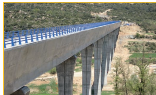
Calzada de servicio proyectada sobre acueducto
