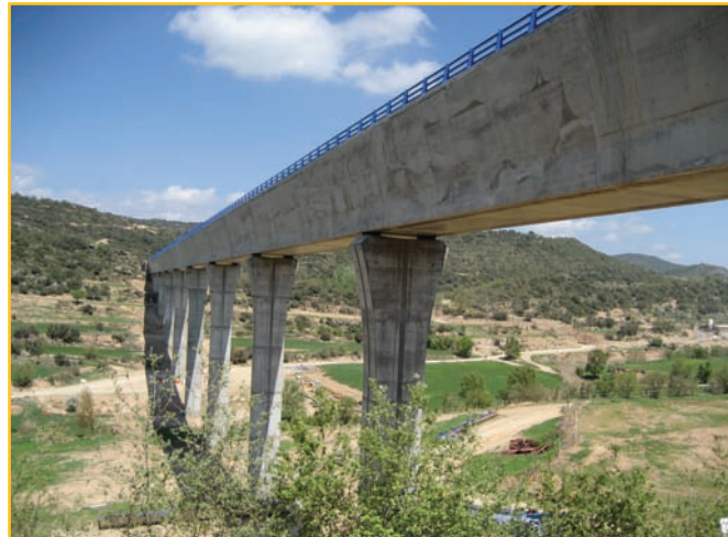
ELASTOMERIC BEARING en las 9 pilas del acueducto n°2
