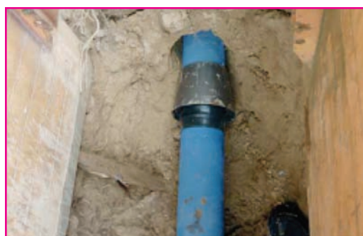
Emplazamiento de maquinaria de Bursting y entrada de tubería
