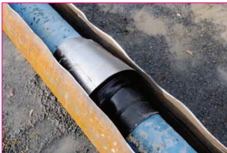
Junta de tracción BLS con revestimiento ZMU y cono de protección (Duktus)
