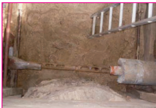
Fotos de cata de fractura. La tubería reforzada es empujada contra el dispositivo de fractura, y los fragmentos caen directamente en el pozo intermedio.
