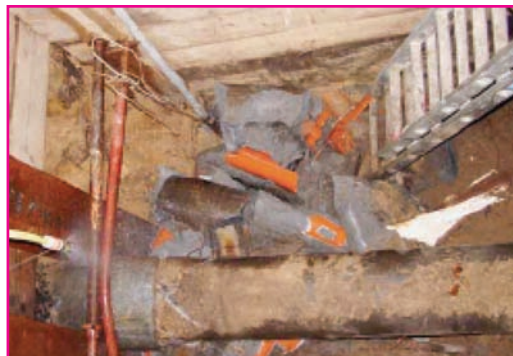
Fotos de cata de fractura. La tubería reforzada es empujada contra el dispositivo de fractura, y los fragmentos caen directamente en el pozo intermedio.
