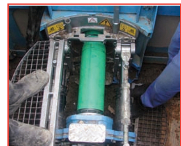
Empuje de la tubería nueva
