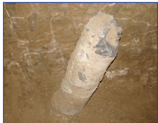
Micropilote mediante inyección dinámica
