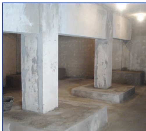
Vista de sótano terminado
