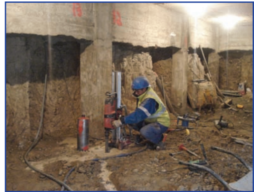
Perforación con diamante de zapata de cimentación
