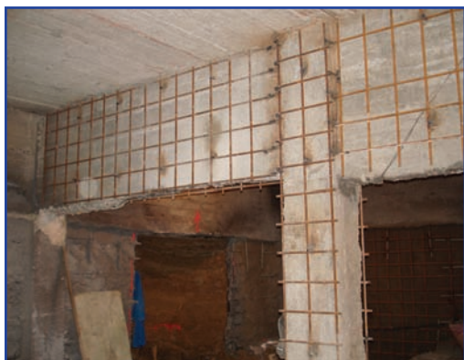
Refuerzo de viga y pilares del sótano.
