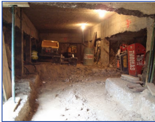
Excavación de sótano por medios mecánicos.
