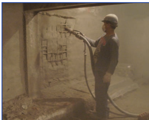
Ejecución de muro de hormigón proyectado
