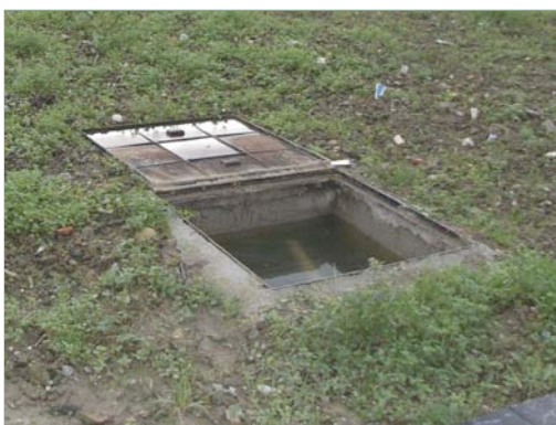
Arqueta de captación.
