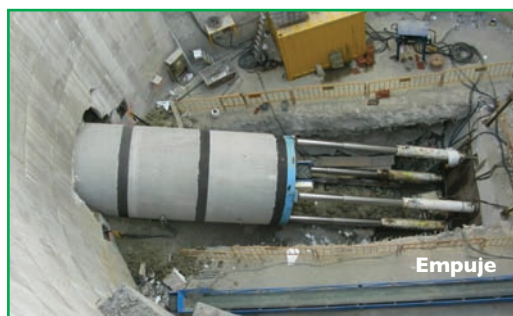
Excavación en el frente con brazo de retro
