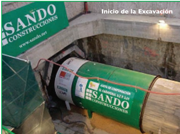
Salida de la tuneladora
