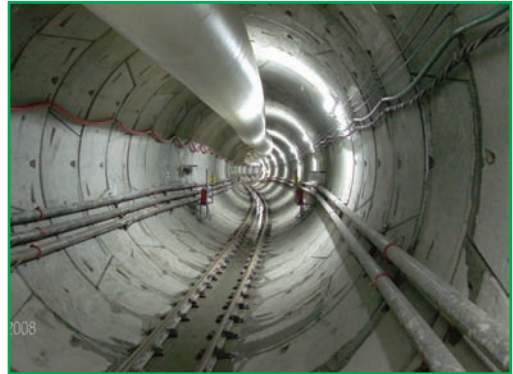
Revestimiento con dovelas
