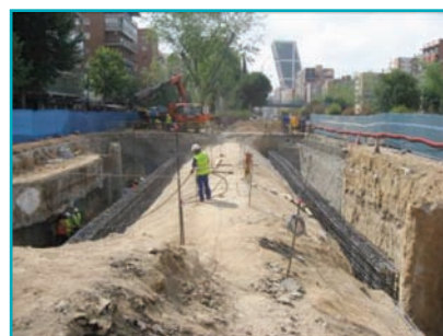
Fotos 9 y 10. Colocación de las armaduras de las vigas de apeo.
