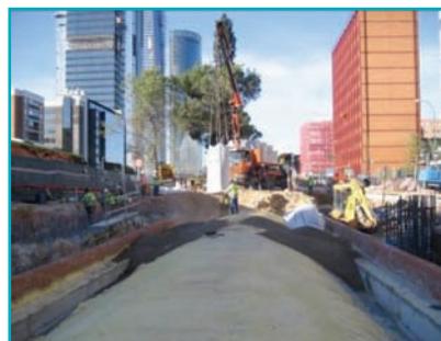
Fotos 19, 20 y 21. Colocación de arcilla expandida sobre la galería.
