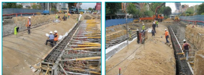
Fotos 14 y 15. Encofrado y hormigonado de las vigas de apeo.
