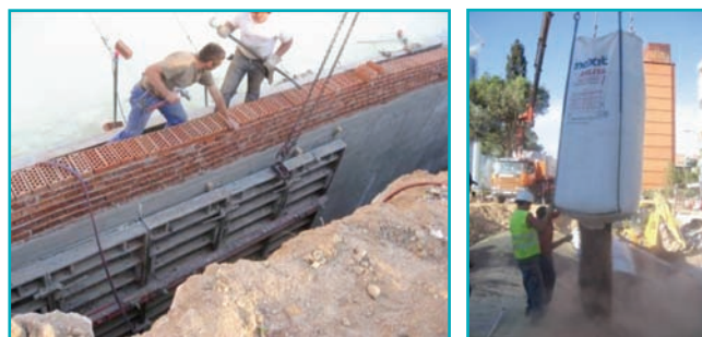
Fotos 19, 20 y 21. Colocación de arcilla expandida sobre la galería.
