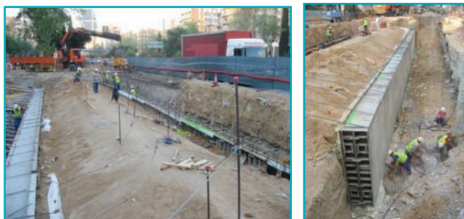
Fotos 16, 17 y 18. Vigas de apeo ya hormigonadas y desencofradas.
