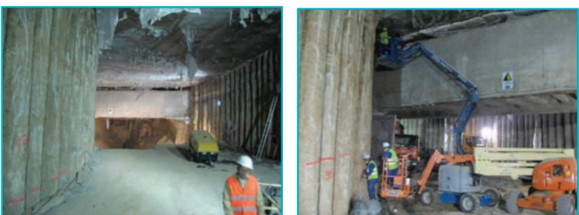
Fotos 35 y 36. Vistas generales de la estructura de apeo ya terminada.
