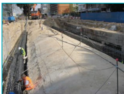
Fotos 9 y 10. Colocación de las armaduras de las vigas de apeo.
