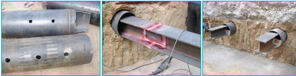
Fotos 6, 7 y 8. Detalle de los tubos hincados y los perfiles colocados transversalmente bajo la solera.
