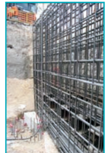
Fotos 11, 12 y 13. Detalles del armado y del apoyo de las vigas de apeo.
