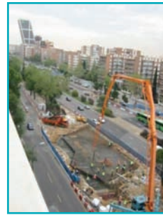
Fotos 22, 23 y 24. Retirada de la arcilla expandida y ejecución de losa de cubierta sobre la galería.
