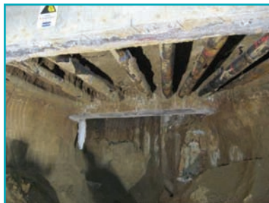
Fotos 22, 23 y 24. Retirada de la arcilla expandida y ejecución de losa de cubierta sobre la galería.
