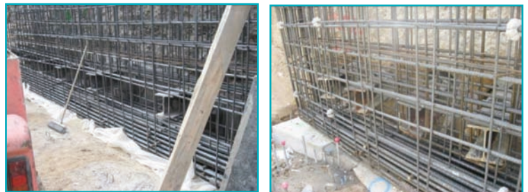
Fotos 11, 12 y 13. Detalles del armado y del apoyo de las vigas de apeo.
