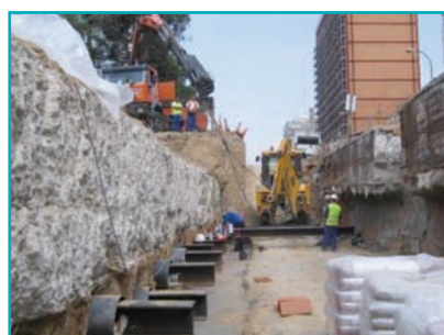
Fotos 4 y 5. Rebaje del espesor de los hastiales y colocación de los perfiles en los tubos.
