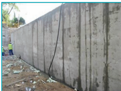
Fotos 16, 17 y 18. Vigas de apeo ya hormigonadas y desencofradas.
