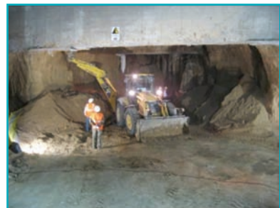
Fotos 22, 23 y 24. Retirada de la arcilla expandida y ejecución de losa de cubierta sobre la galería.
