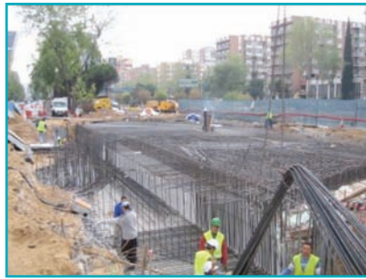
Fotos 22, 23 y 24. Retirada de la arcilla expandida y ejecución de losa de cubierta sobre la galería.
