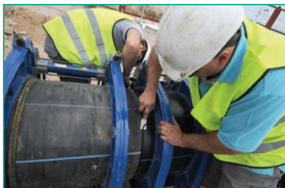
Detalle de la soldadura y eliminación de rebaba.
