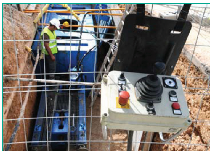
Posicionamiento del equipo en cata
