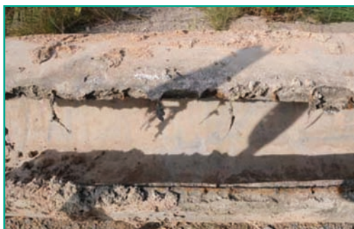
Detalle longitudinal de un corte de la tubería existente de la cata de ataque
