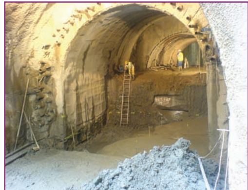
Fig. 11. Fotografía de uno de los túneles durante la fase de excavación
