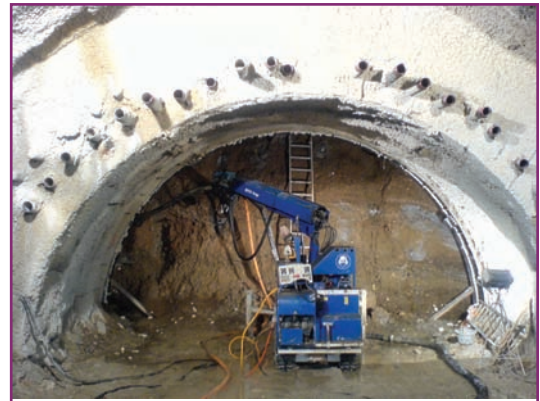
Fig. 8. Gunitado del frente en la excavación de la segunda zona.
