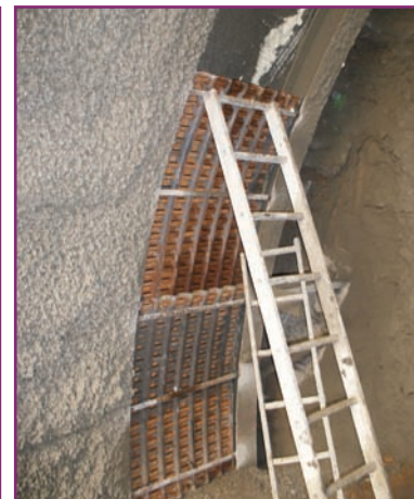
Fig. 10. Excavación del túnel con el sistema de chapa Bernold y gunita
