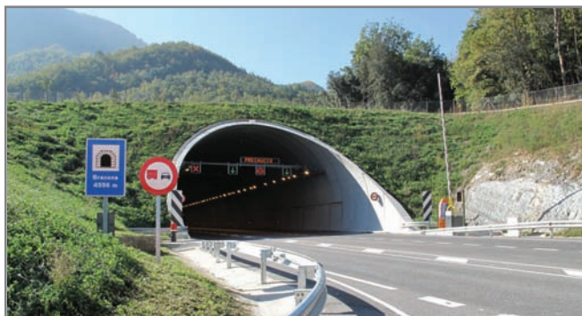
Túnel de Bracons
